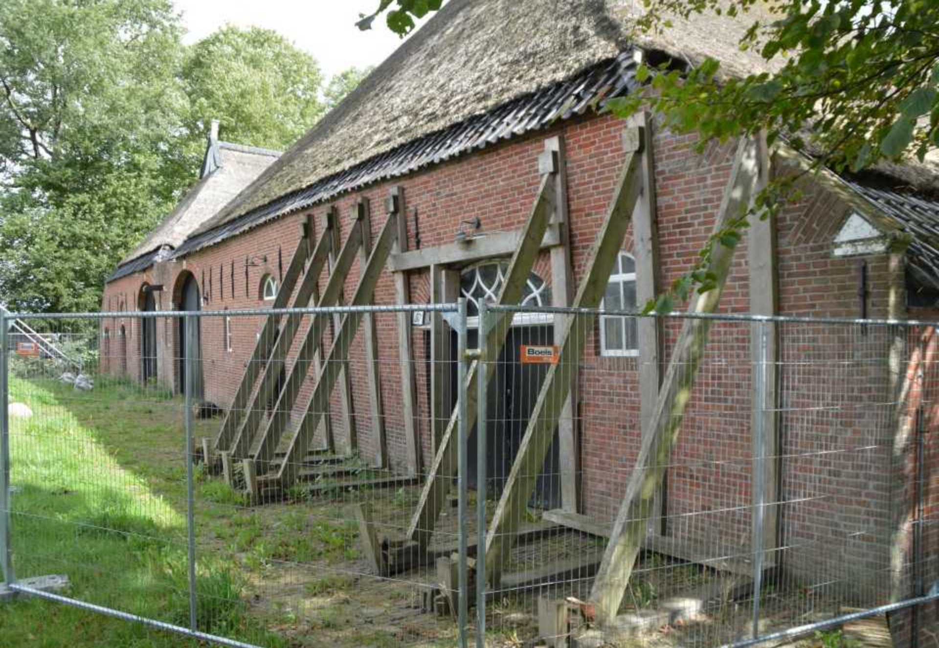
Erdbebenschaden im Erdgasfeld Groningen/Niederlande
