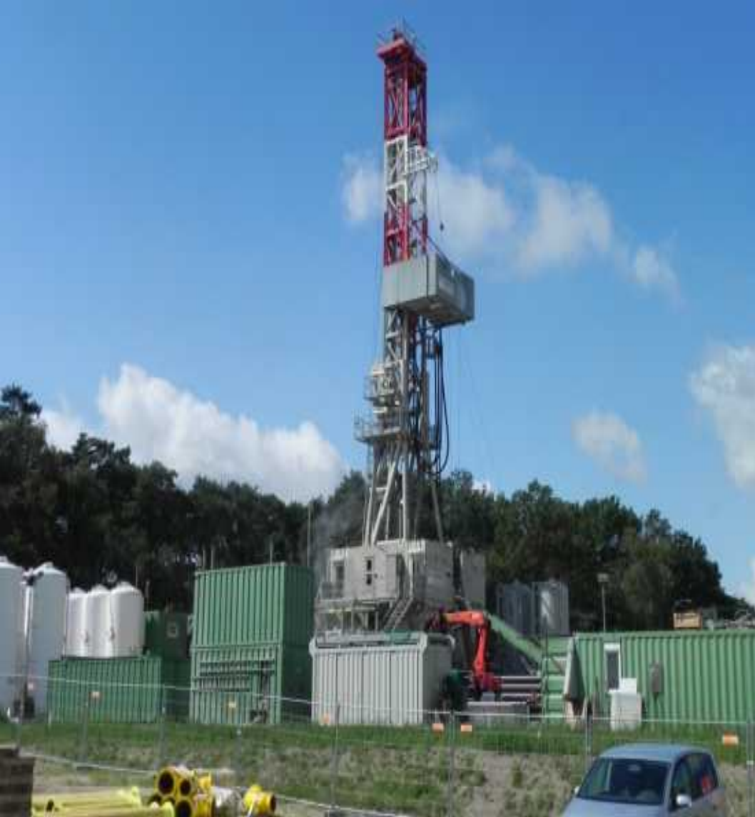
Explorationsbohrung (Bayerngas) nach Erdgas bei Beeskow
