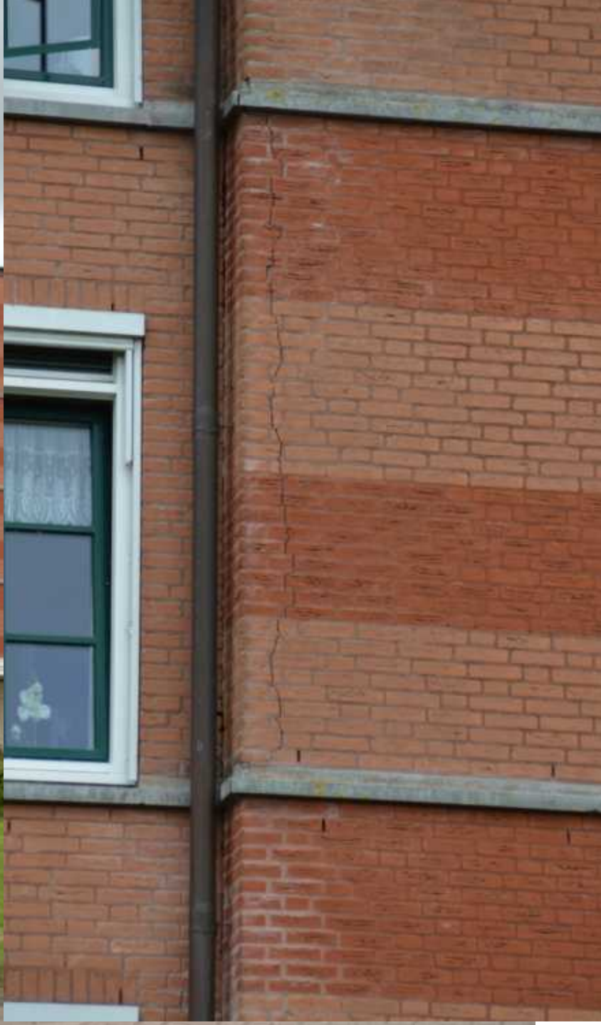
Schadenserscheinungen im Erdgasfeld Groningen/Niederlande
