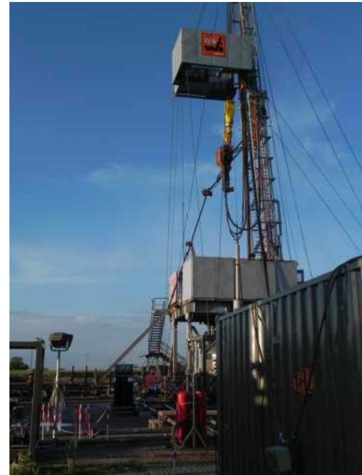
Bohrturm auf Barth 11 bei Saal/ Vorpommern zur Vorbereitung einer hydraulischen Stimulation (Fracking) in einer Erdöl-Lagerstätte (Staßfurt-Karbonat)
